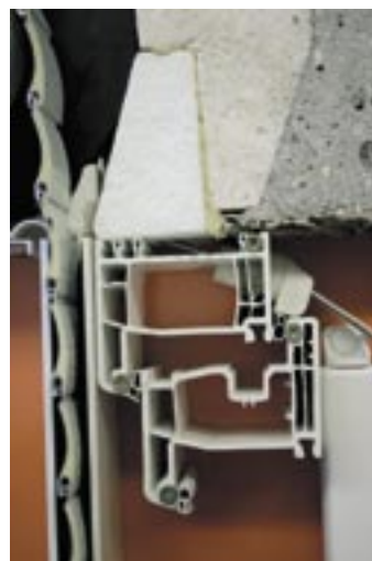
DETAIL ŘEZU ROLETOVÝM PŘEKLADEM 220/R S VENKOVNÍ ROLETOU
